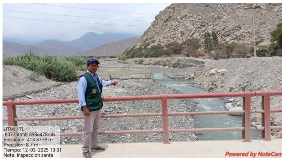
Visita al Rio Nepeña, tramos críticos.
