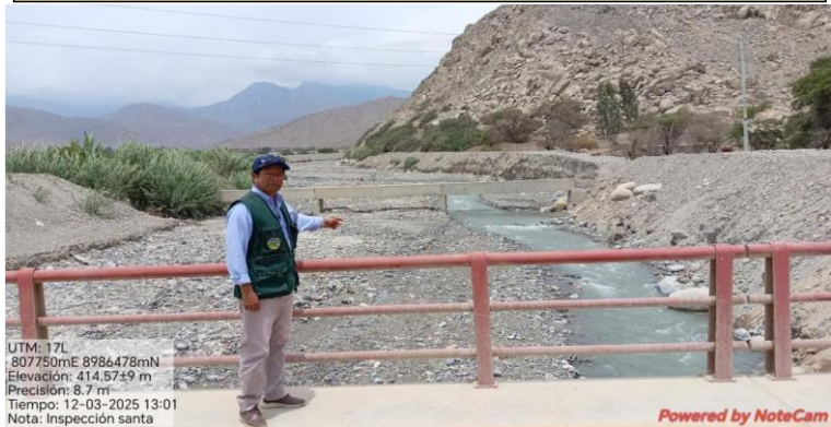
Visita al Rio Nepeña, tramos críticos.
